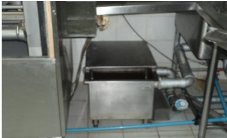
รูปที่ 2 แสดงถังดักไขมันใต้อ่างล้าง
